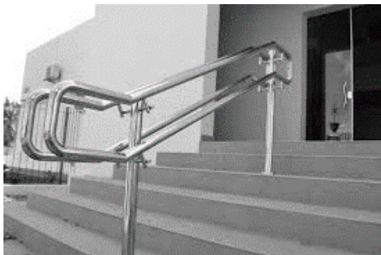
Figura 8: Corrimão acessível contínuo no centro da escada
