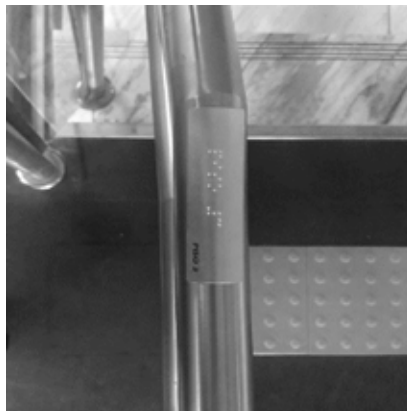
Figura 2: Sinalização em Braille, informando o número do pavimento
