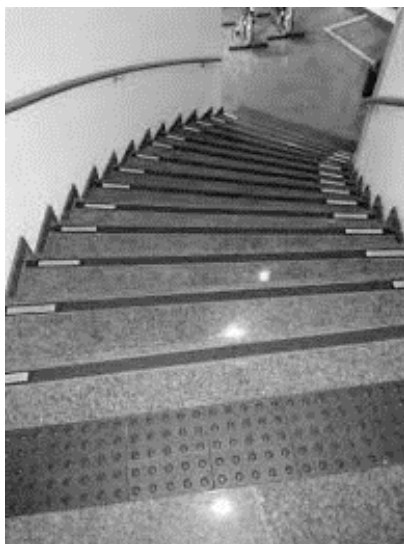
Figura 6: Sinalização tátil de alerta no início e no final da escada, em contraste com o piso
