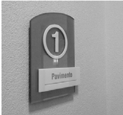
Figura 1: Sinalização de alto relevo, informando o número do pavimento
